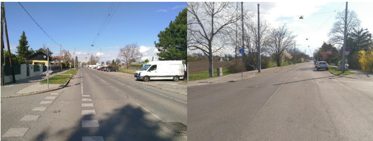
Abbildung 12: Ruthnergasse auf Höhe Katharina-Scheiter-Gasse mit Mehrzweckstreifen (linkes Bild, Blick Richtung Norden), die in einem einseitigen gemischten Geh- und Radweg übergeht (rechts Bild Blick Richtung Süden).
